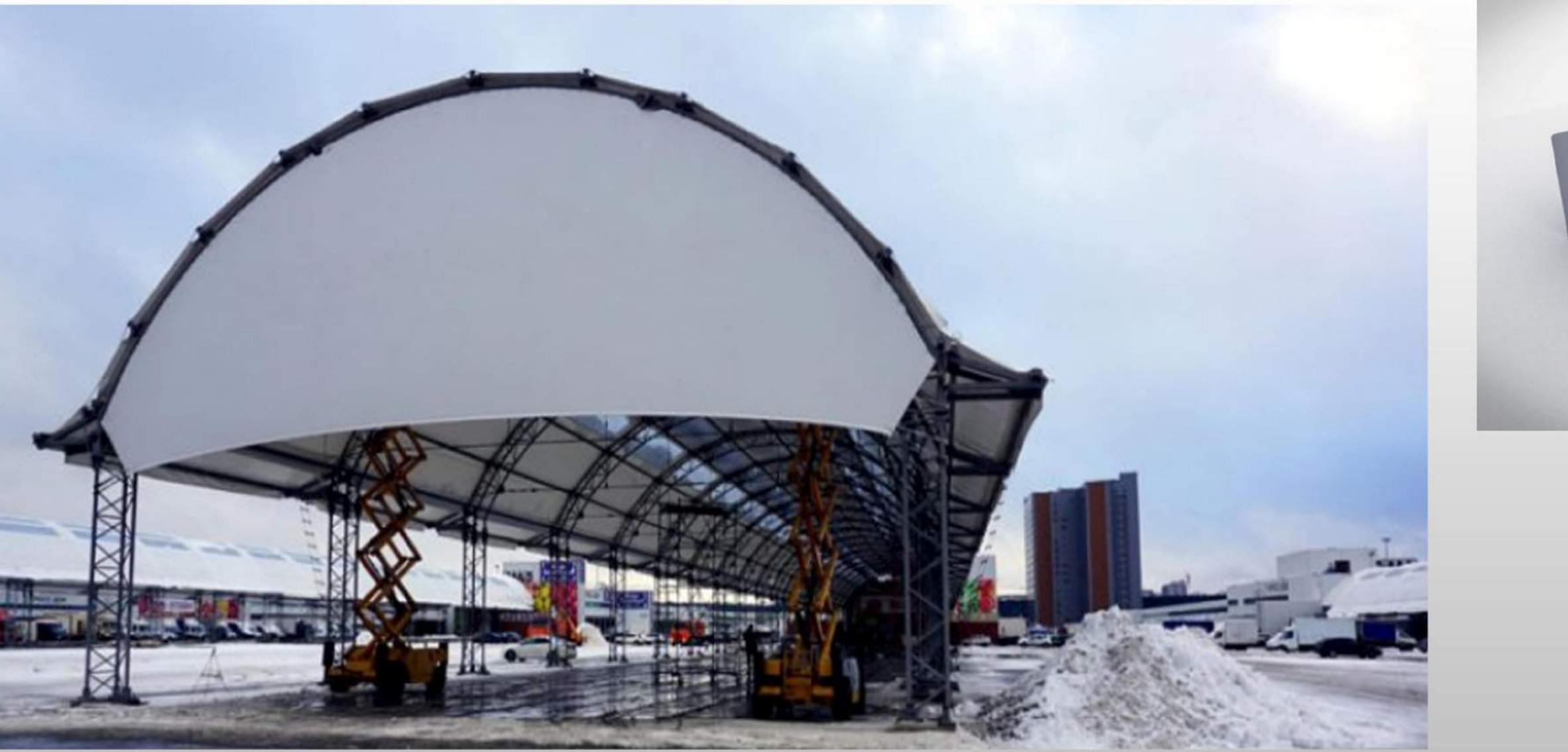
Мембранные конструкции – это сложнейшие инженерные сооружения, в которых действуют большие нагрузки от натяжения тента на каркас и аэродинамические нагрузки. Иногда к ним добавляются сугробовые нагрузки на поверхность тентовой кровли. Все это в купе предъявляет повышенные требования к профессионализму и инженерному опыту специалистов, занимающихся производством и монтажом мембранных конструкций.
